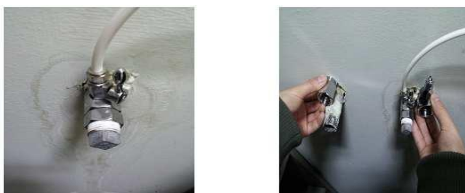
Рис. 5. Установка водопроводного крана в другом варианте (без подключения к мойке)
